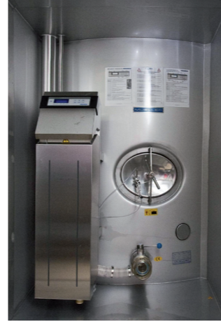
Silo odasının Milil Soğutma & temizleme kontrol sistemi ile birlikte paslanmaz çelik oda
